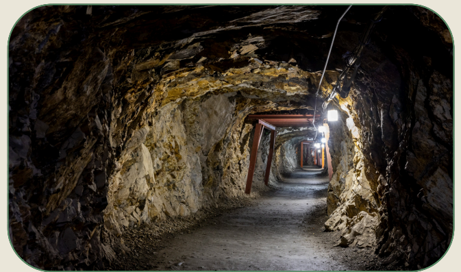
松代大本営地下壕 （長野市）
